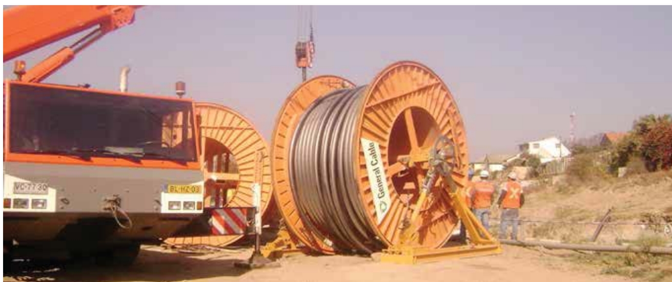
Instalación de cable de alta tensión bajo lecho del estero Marga-marga.
